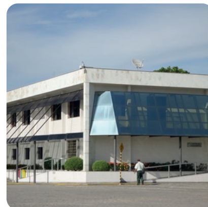
Prédio da Administração
