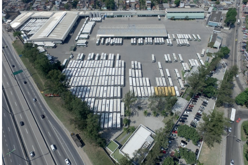
Vista aérea da garagem
